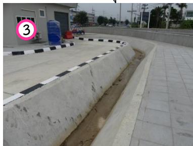
รางระบายน้ำจากเครื่องสูบน้ำ
