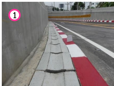
รางระบายน้ำภายในอุโมงค์ทางลอด
